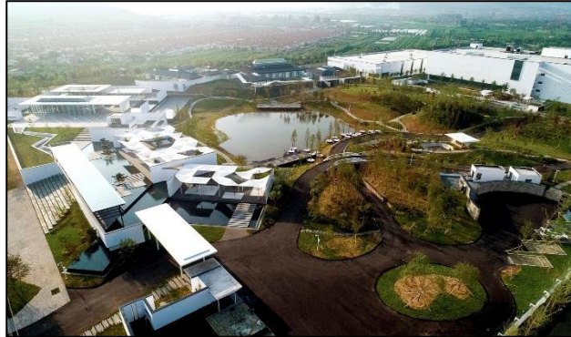
Figura 27: Vista superior do parque industrial.
